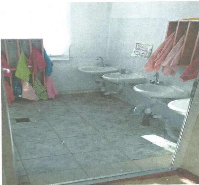
Существующая санитарная комната имеет ненормативные размеры в плане. Она не соответствует требованиям п.5.3 СП 59.13330.2012. Но в связи с тем, что конструкции здания невозможно изменять по техническо-конструктивным требованиям, предлагается до реконструкции использовать туалет только для МГН категорий «Г» и «С». Следовательно, использовать ее для инвалидов категории «К» и «О» невозможно.
